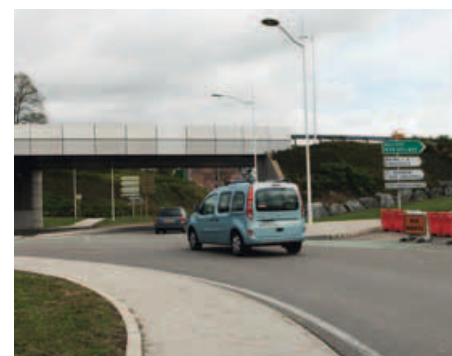
↑ LE GIRATOIRE DU FORT BENOÎT PENDANT LES TRAVAUX.
