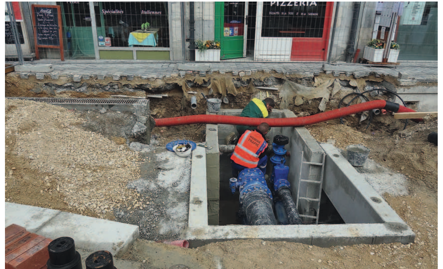
D'IMPRESSONNANTS TRAVAUX SUR LES RÉSEAUX SONT ENCORE EN COURS SUR LA PLACE. ↑
