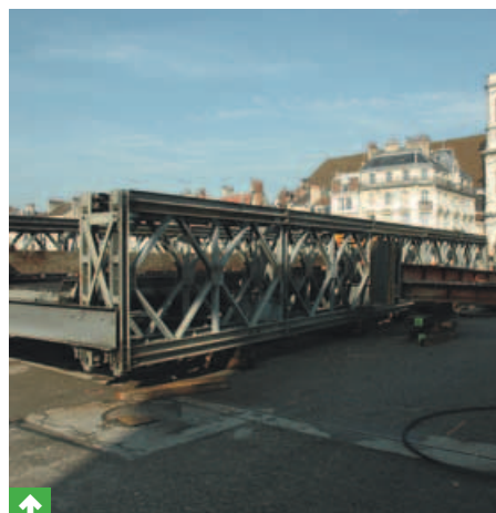
↑ LA PASSERELLE PIÉTONNE LIVRÉE EN KIT SUR LE PONT BATTANT.
